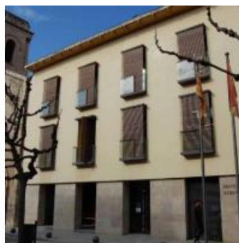
Edificio administrativo del Ayuntamiento de Fraga
